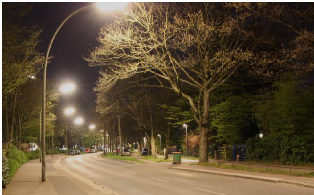
Bild 6 Friedensallee, Beginn der Gehwegbeleuchtung
